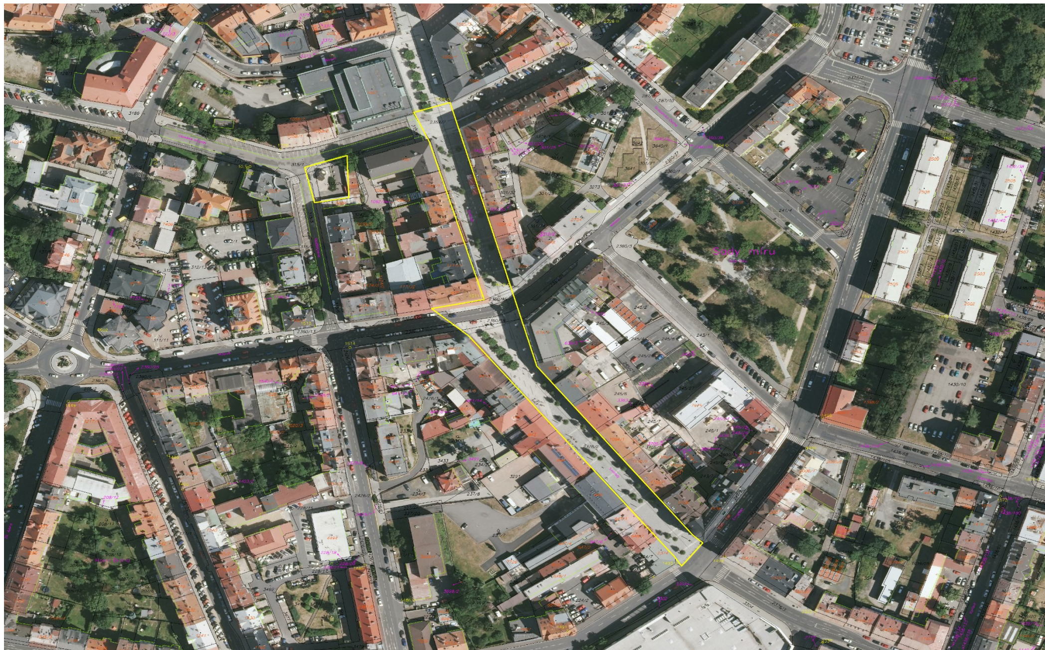
Budova č. p. 2064 - ulice Valdštejnova (Městská tržnice), část třídy Svobody.
