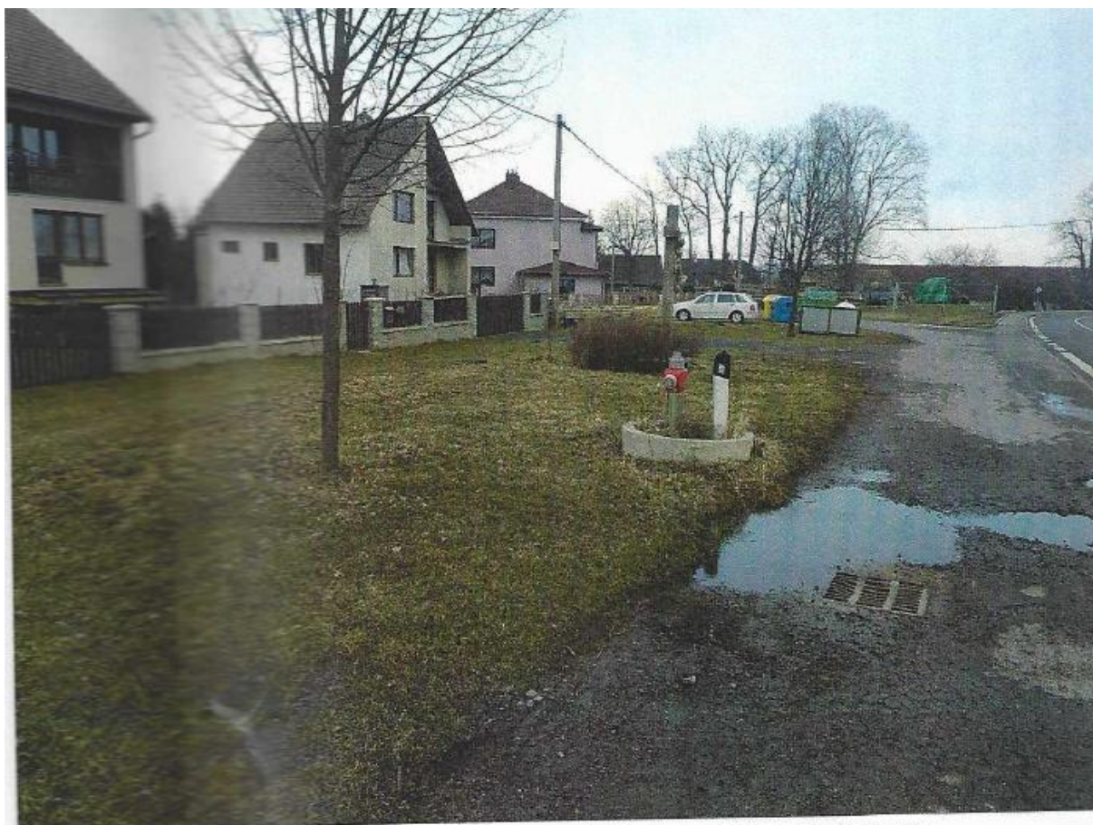
Obrázek 1: Umístění požárního hydrantu v zeleném pásu cca 1,5 m od kraje vozovky.
