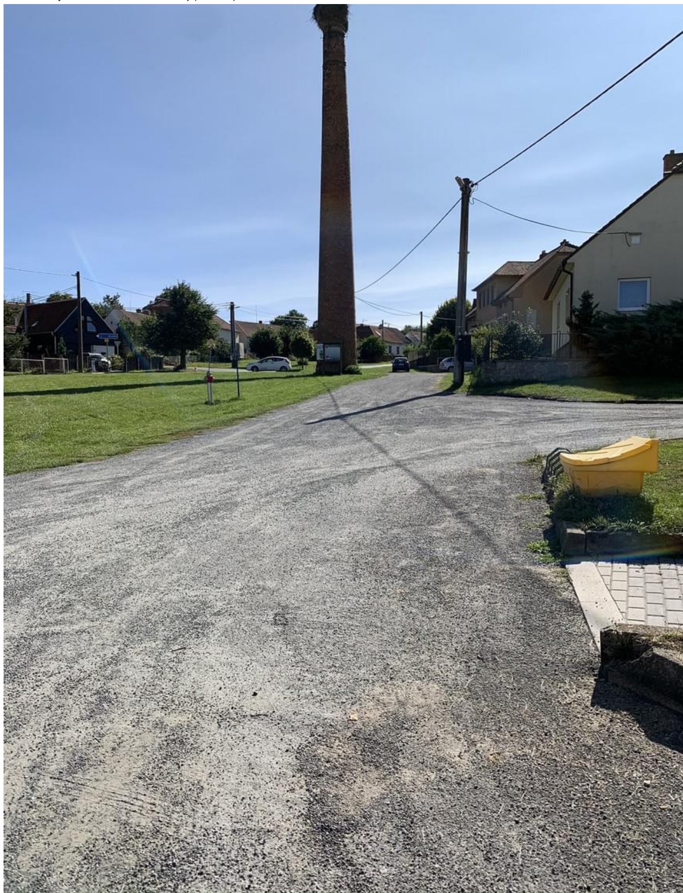
Foto 2: Stávající místní komunikace III. třídy (ozn. 07c)
