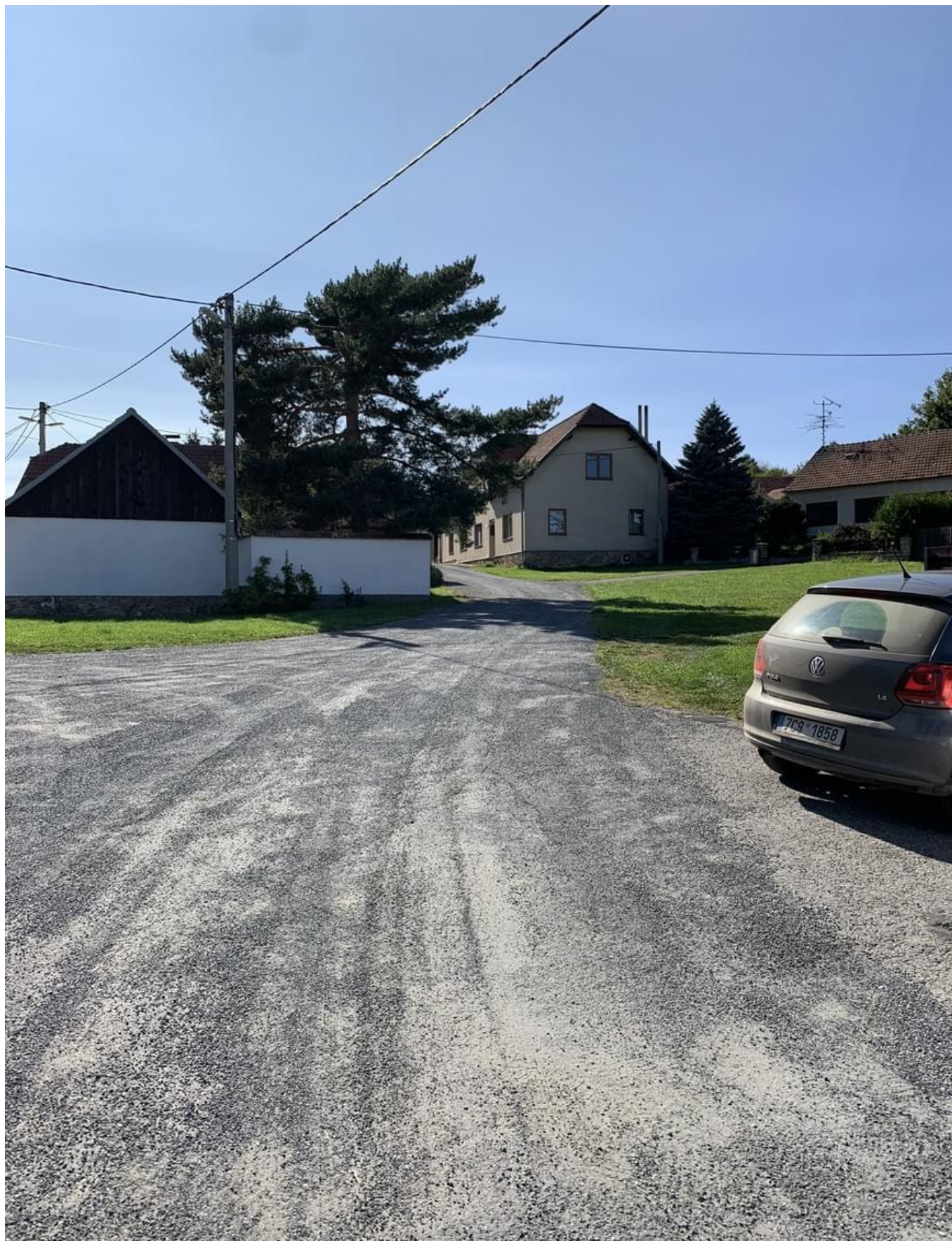
Foto 1: Stávající místní komunikace III. třídy (ozn. 08c)
