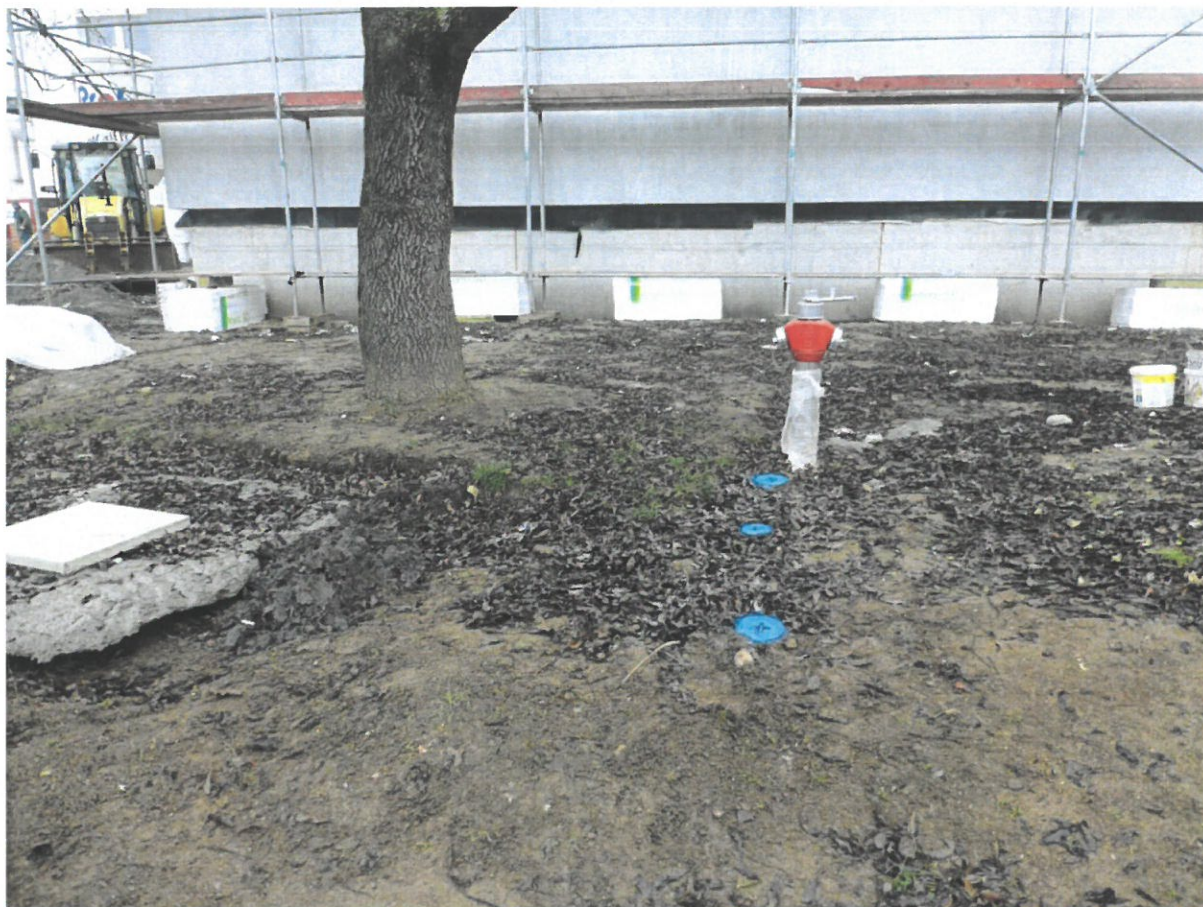
Obrázek 3: Umístění požárního hydrantu na parcele 827místo stávajícího podzemního hydrantu H57. Nutno přepojit na potrubí min DN 80.
